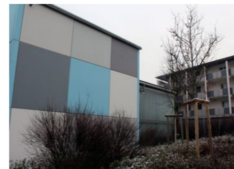
Abb. 21: Beispiel Fürth: Parkhaus mit geschlossener Fassade © LK Argus, 2015
