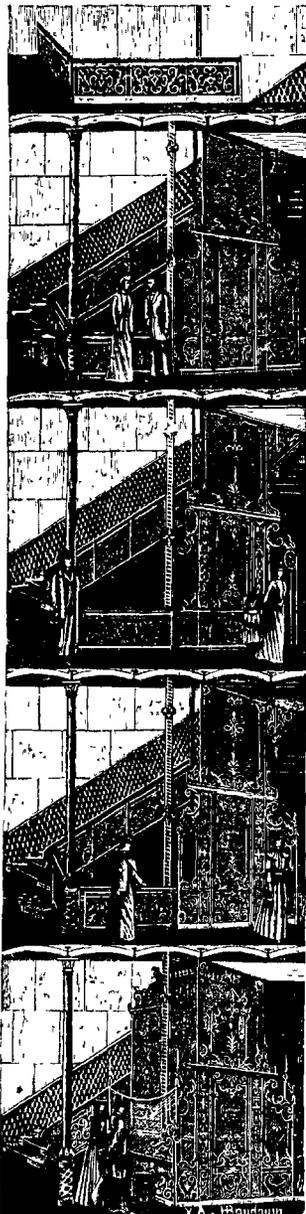
Indirect hydraulisch angetriebener Fahrstuhl im Hôtel Bristol-Berlin.
