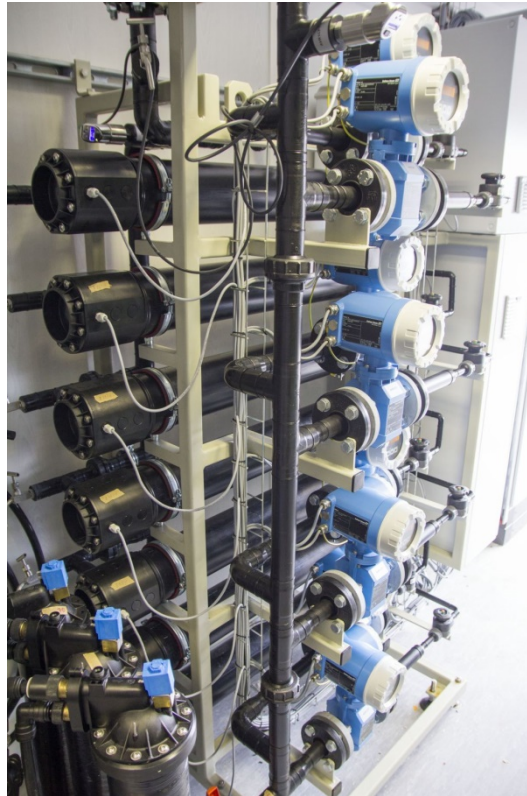
Bild 7.1: Geräte für die elektrochemische Behandlung in einer technischen Versuchsanlage (Bild: Grünbeck Wasseraufbereitung GmbH)
