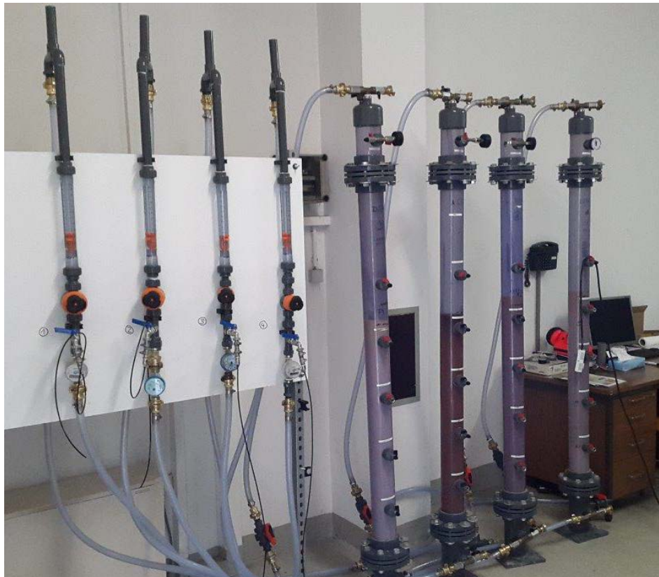
Bild 2.2: Versuchsanlage zur Entfernung von per- und polyfluorierten Verbindungen mittels Ionenaustauschern
