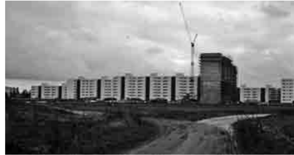
Noch im Bau, Blick vom Magistratsweg auf den Loschwitzer Weg. Die aufsteigenden Gebäuderiegel parallel zur Heerstraße und Loschwitzer Weg stammen aus der Feder des Schülers von Hans Scharoun und ehemaligen Senatsbaudirektors Werner Düttmann, der maßgeblich an der Interbau im Hansaviertel beteiligt war. (Foto Becker)
