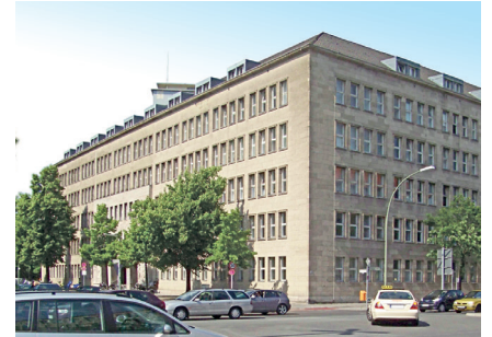
Ansicht des Gebäudes Fehrbelliner Platz 1
