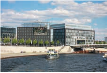
Abb. 31: Büro- und Geschäftshaus
