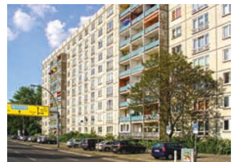
Abb. 43: Betonplattenbauten des komplexen Wohnungsbaus
