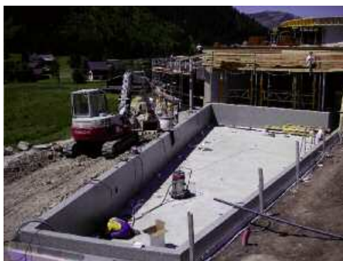
Schwimmbecken (kurz) vor Fertigstellung © StekoX® GmbH
