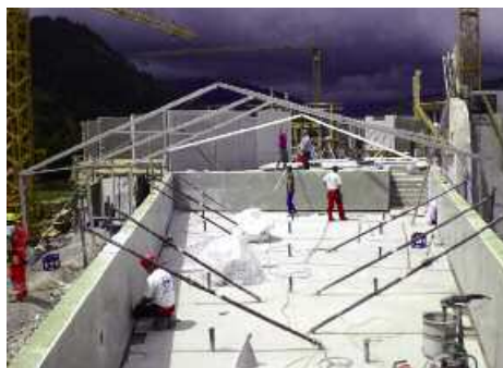
(End-)Montage der Betonelemente © StekoX® GmbH
