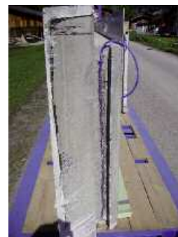
Vorinstallierter Injektionsschlauch © StekoX® GmbH
