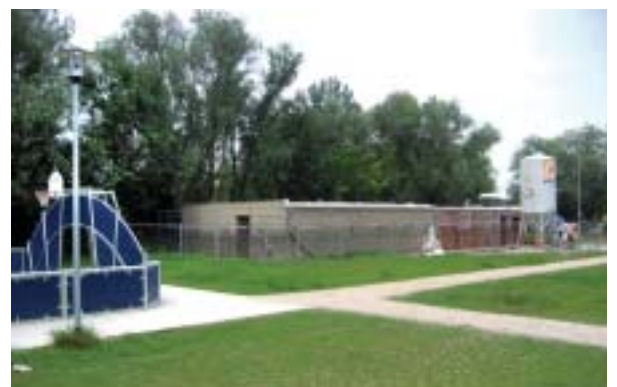
Der Rohbau des Jugendtreffpunktes wurde im Juni verputzt.
