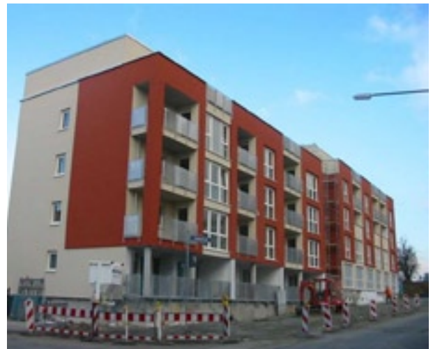
Eine Ansicht des Bauprojektes Generationen übergreifenden Wohnens in Frankfurt-Preungesheim (Quelle: GSW Frankfurt/Main)
