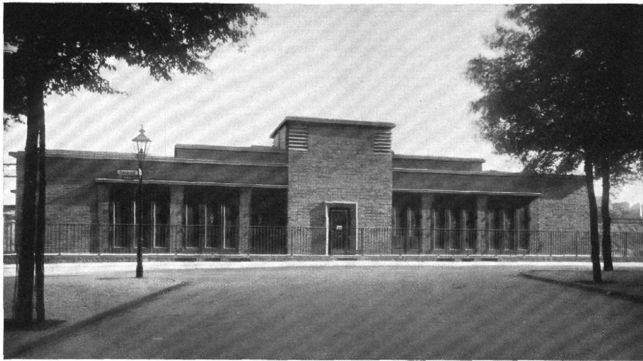
Abb. 1 / Kleingleichrichterwerk Neukölln / Architekt: Richard Brademann, Berlin / Ansicht von der Straße
