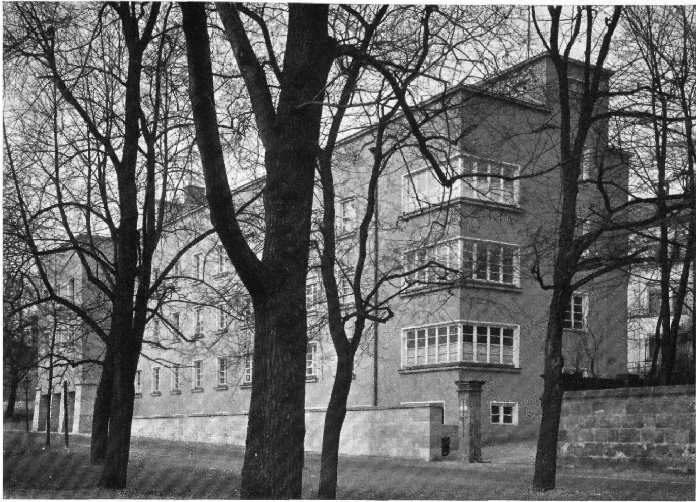
Abb. 1 Krankenhausbau Hallerwiese in Nürnberg / Architekt: German Bestelmeyer, München / Ansicht von der Hallerwiese mit den Eckfenstern der Tagesräume
