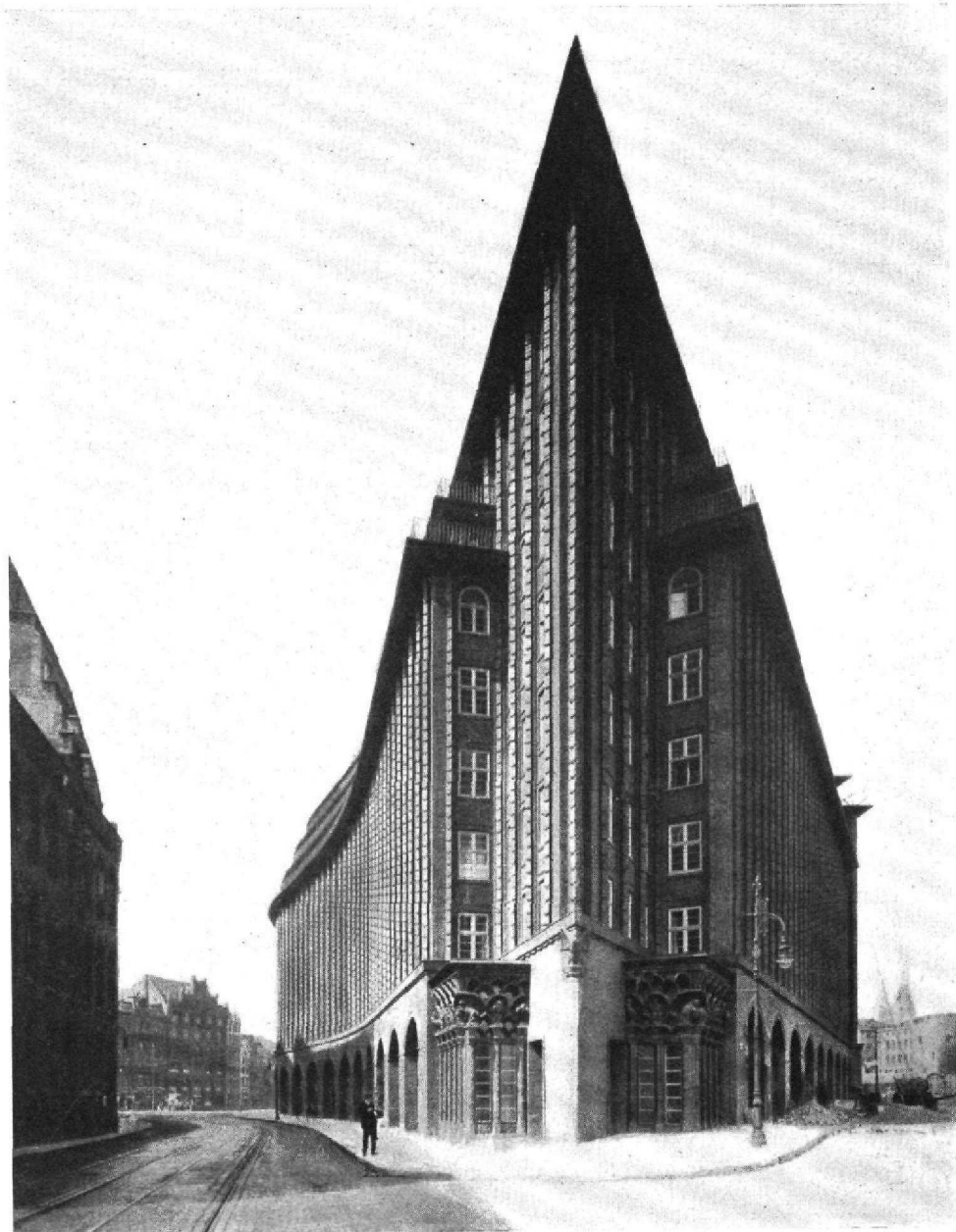
DAS CHILE-HAUS IN HAMBURG / ARCHITEKT: FRITZ HÖGER / BLICK AUF DIE SPITZE Hauptgesims mit 1,20 m Ausleitung, welche an der scharfen Ecke 3,70 m ausmacht.
